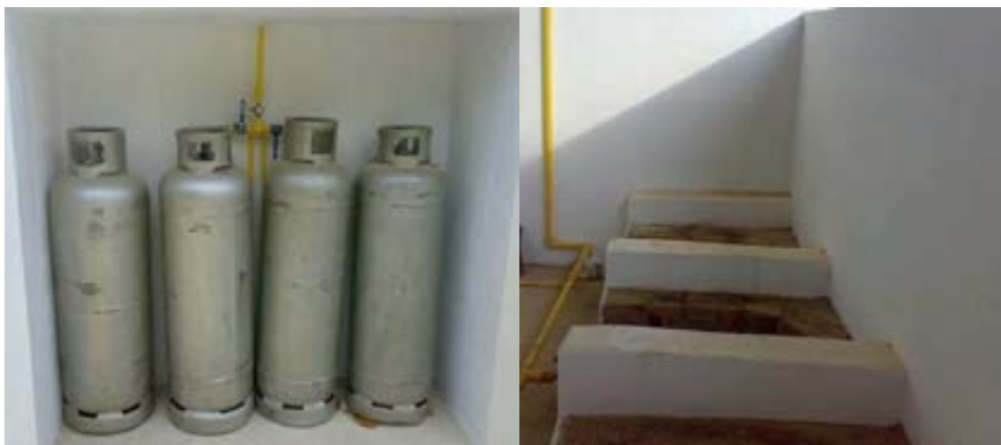
Foto 9. Fornalha a gás com queimadores industriais. Direito de imagem cedido pela AEUDV. Foto: Wagner Lira.
